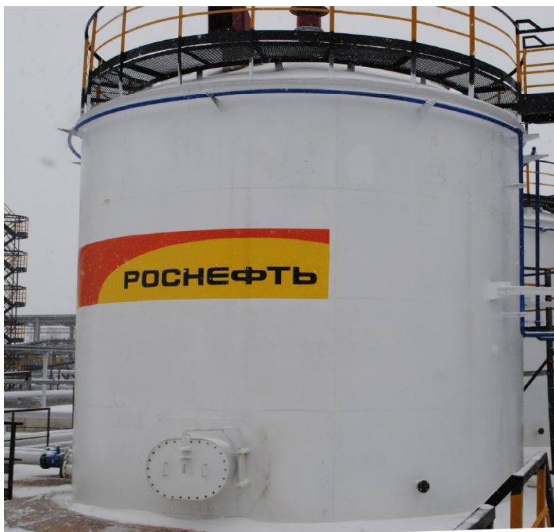
Рисунок 1 - Общий вид резервуара стального вертикального цилиндрического РВСП-200
