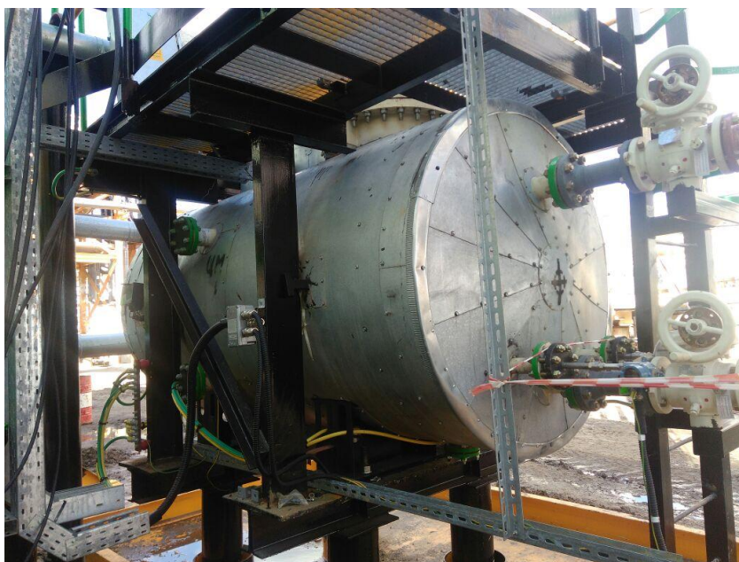
Рисунок 1 - Общий вид резервуара РГС-2,5
